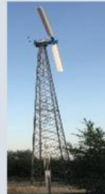
Krogmann 15-50 50 kW, Ø Rotor 15 m
